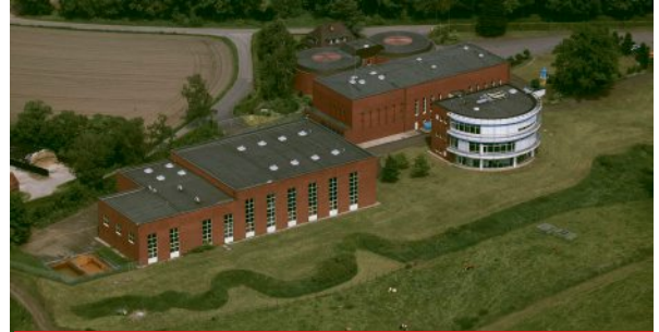
RWW-Wasserwerk Holsterhausen Am Kreskenhof 66, www.rww.de
